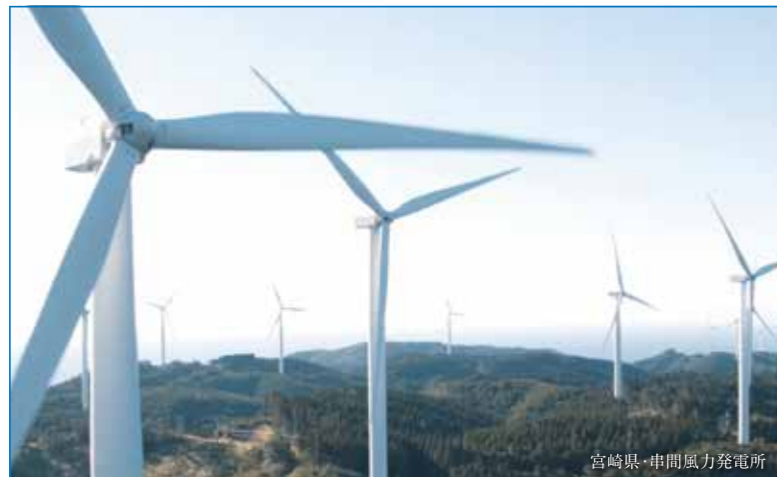
宮崎県・串間風力発電所
